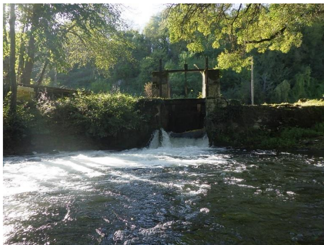
Figure 35 : vanne du moulin de Beudant le 25/10/2023
