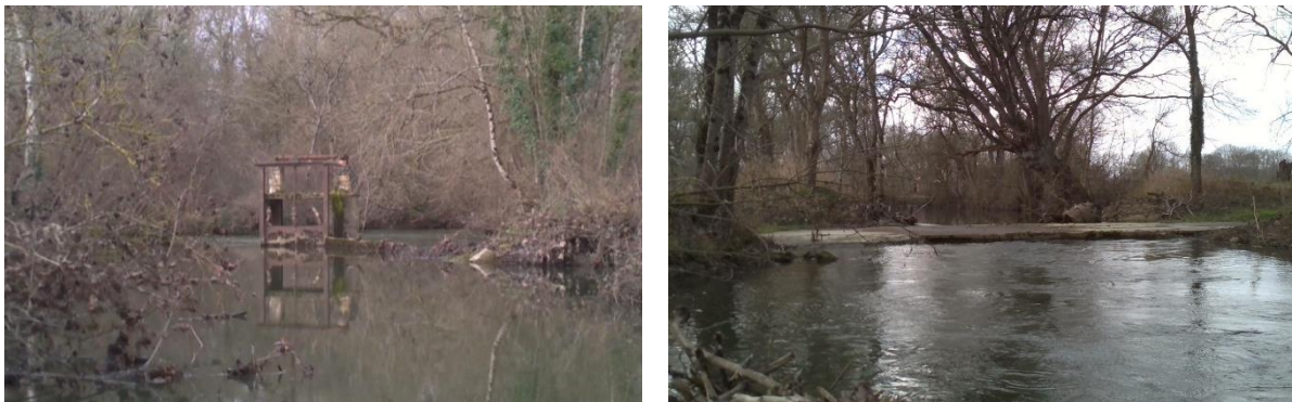
Figure 39 : exemple d'ouvrages infranchissables présents sur les bras secondaires : à gauche une vanne avec un seuil (la Chapelle), à droite un passage à gué en béton (Vouharte)
