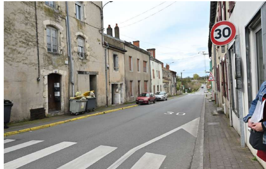
La rue du Général Leclerc à restructurer
