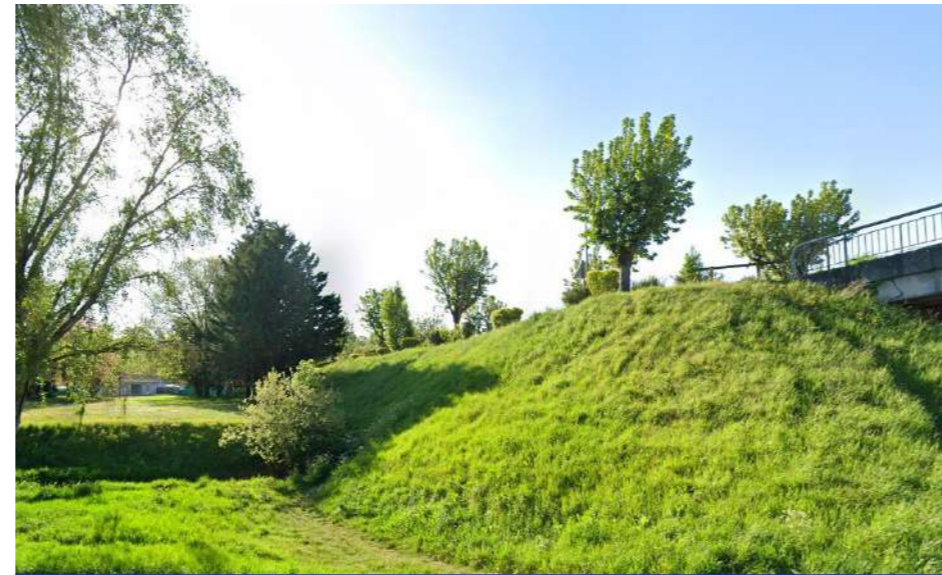
Talus du boulevard des Grands Rocs
