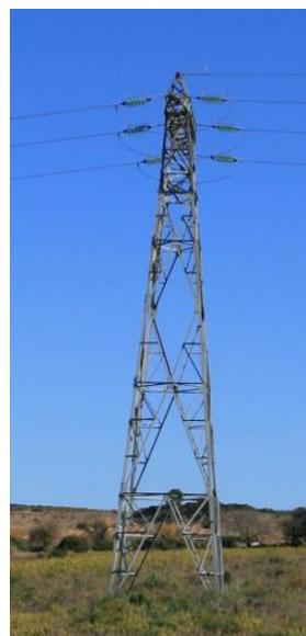
La superstructure correspond à un treillis métallique composé de « barres » ou de « cornières » constituant et assurant la rigidité de l'ensemble du pylône.
