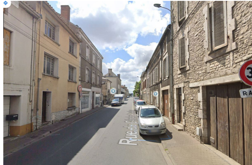
Etat actuel rue du Général Leclerc
